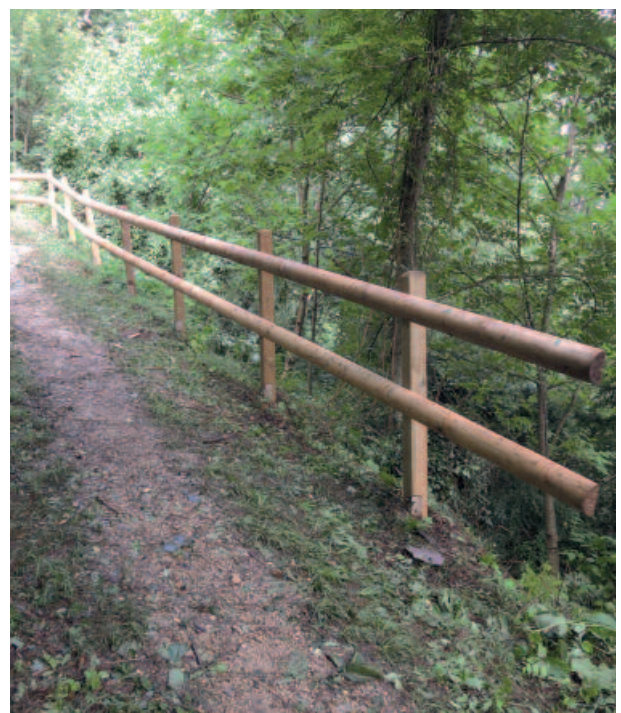
Das Holzgeländer ist fertig gebaut
