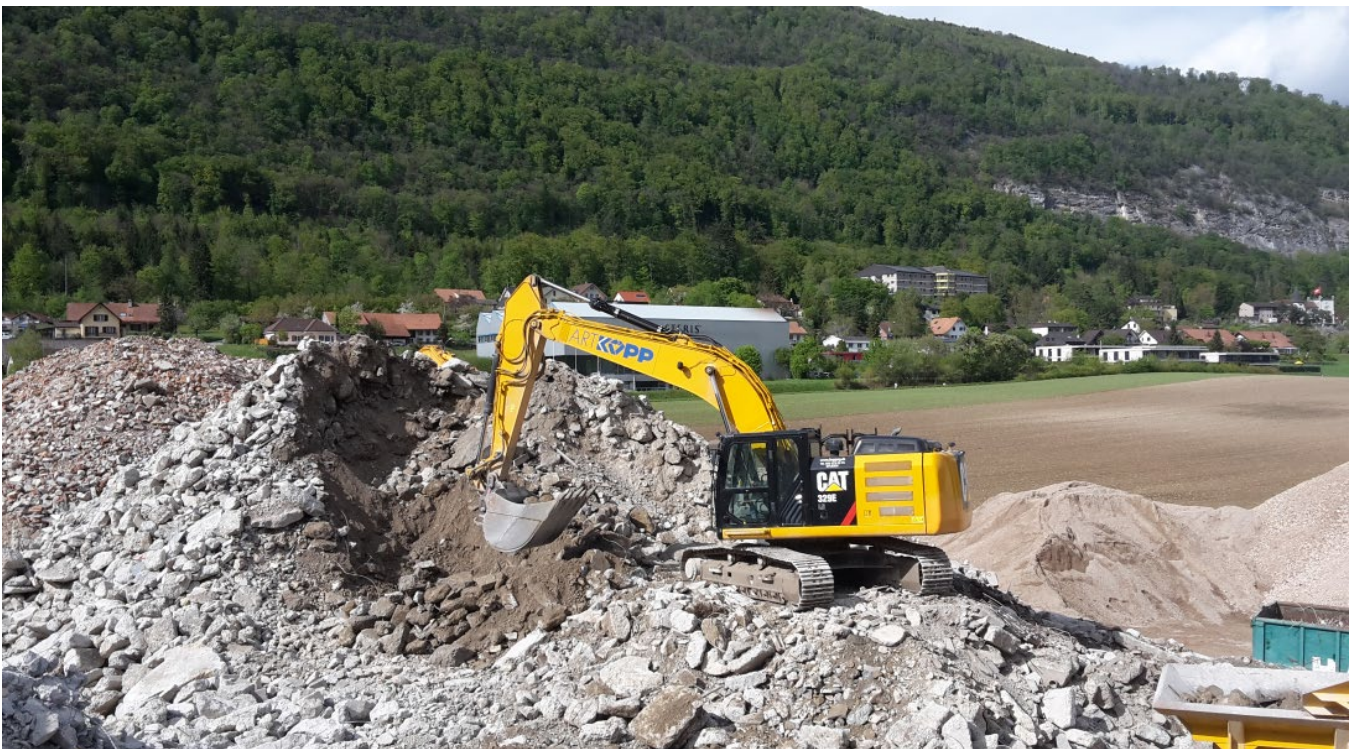
Das Abbruchmaterial wird aufgeschüttet und zwischengelagert...
