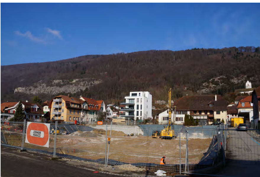
Mitten im Dorf entstehen auf dem ehemaligen Areal der Bau-firma Ihly nun 48 Wohnungen 2 ½ bis 5 Zimmer mit einer unterirdischen Einstellhalle. In der Überbauung ist auch das Ärztezentrum vorgesehen.
