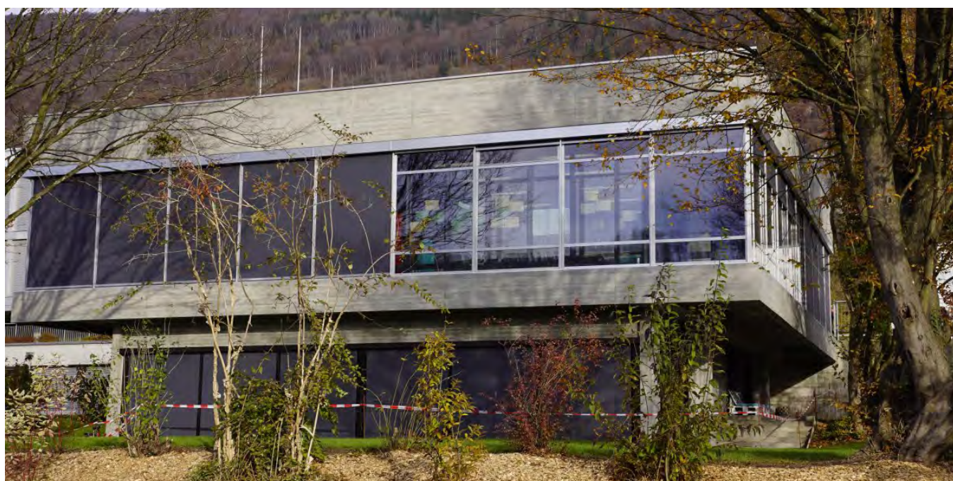
Das Erscheinungsbild der ehemaligen Aula konnte gewahrt werden
