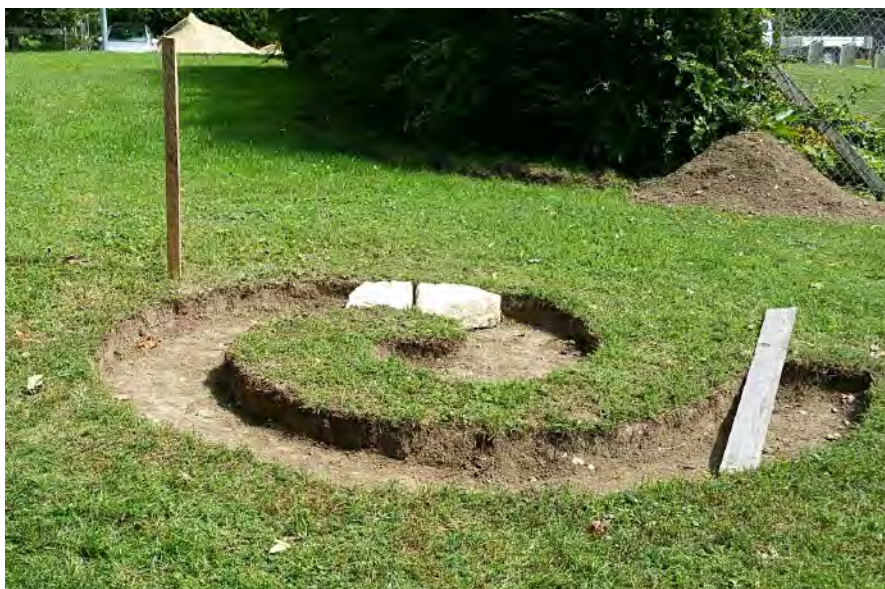
Das Fundament ist ausgehoben
