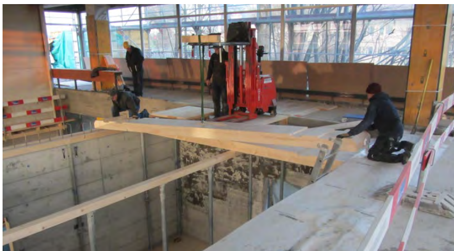
Die neue Decke aus Holz wird verlegt
