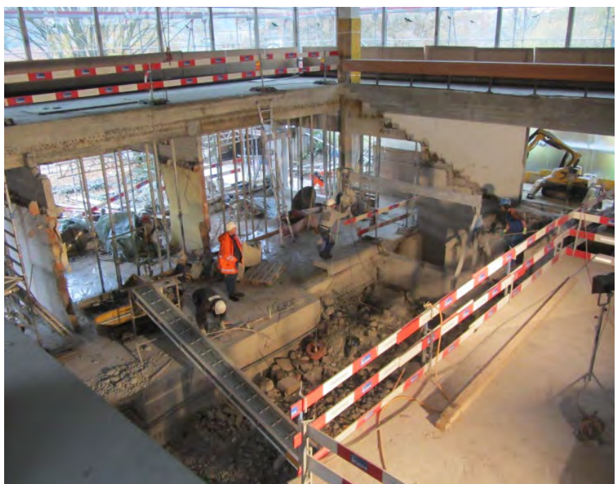
Rückbau der Besuchertribüne
