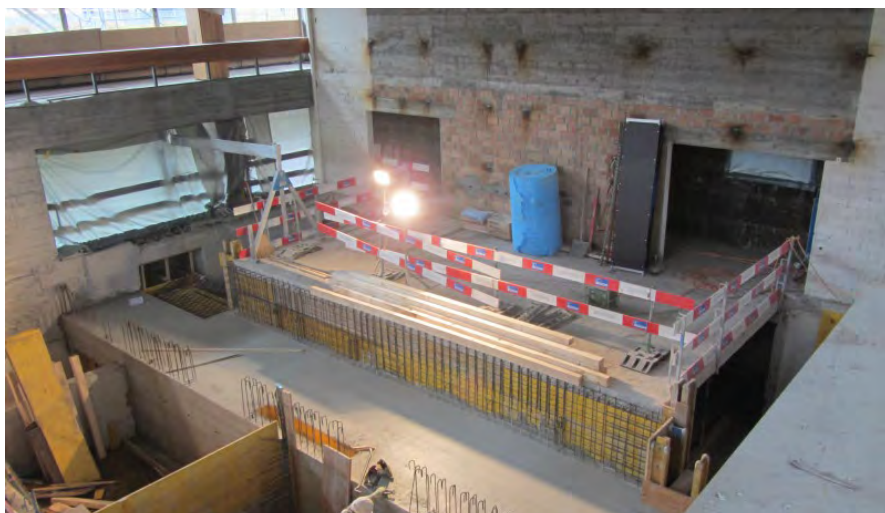
Die Abbrucharbeiten waren aufwändig und lärmintensiv
