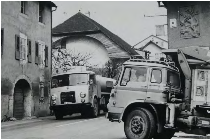
Ehemalige Kreuzung Klösterlirain-Solothurnstrasse...
