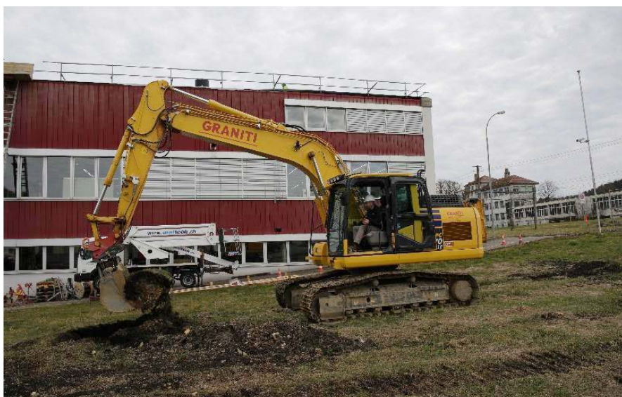
Spatenstich durch den Geschäftsführer Bernhard Stähli
